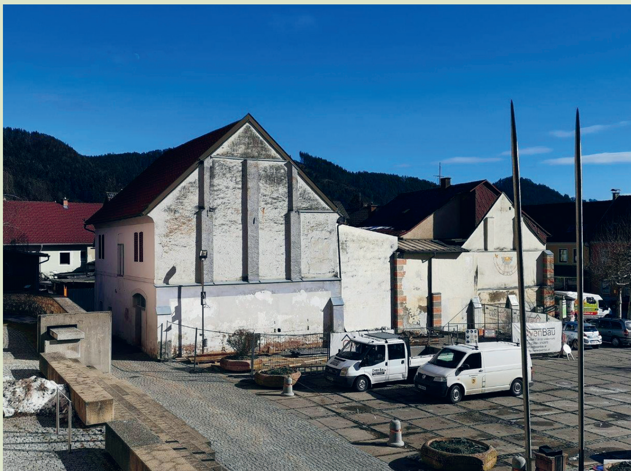
Das ehemalige Geschäftsgebäude am Kirchplatz wurde von der Gemeinde erworben, saniert und zu einem Zentrum der Begegnung umgebaut. (Foto: Gemeinde Griffen)
