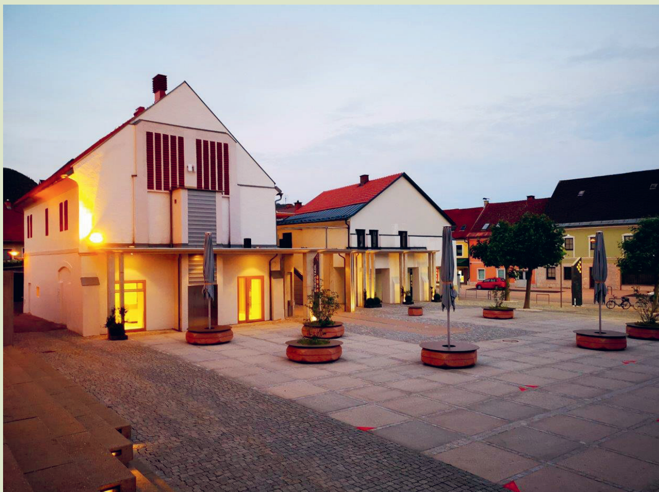
Im revitalisierten Stadl befinden sich ein Museum sowie ein Kultur- und Ausstellungssaal, der auch als Trauungssaal der Gemeinde dient. (Foto: Gemeinde Griffen)
